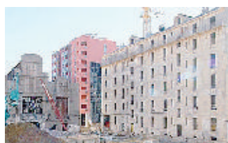
Cantieri alla foce del fiume
