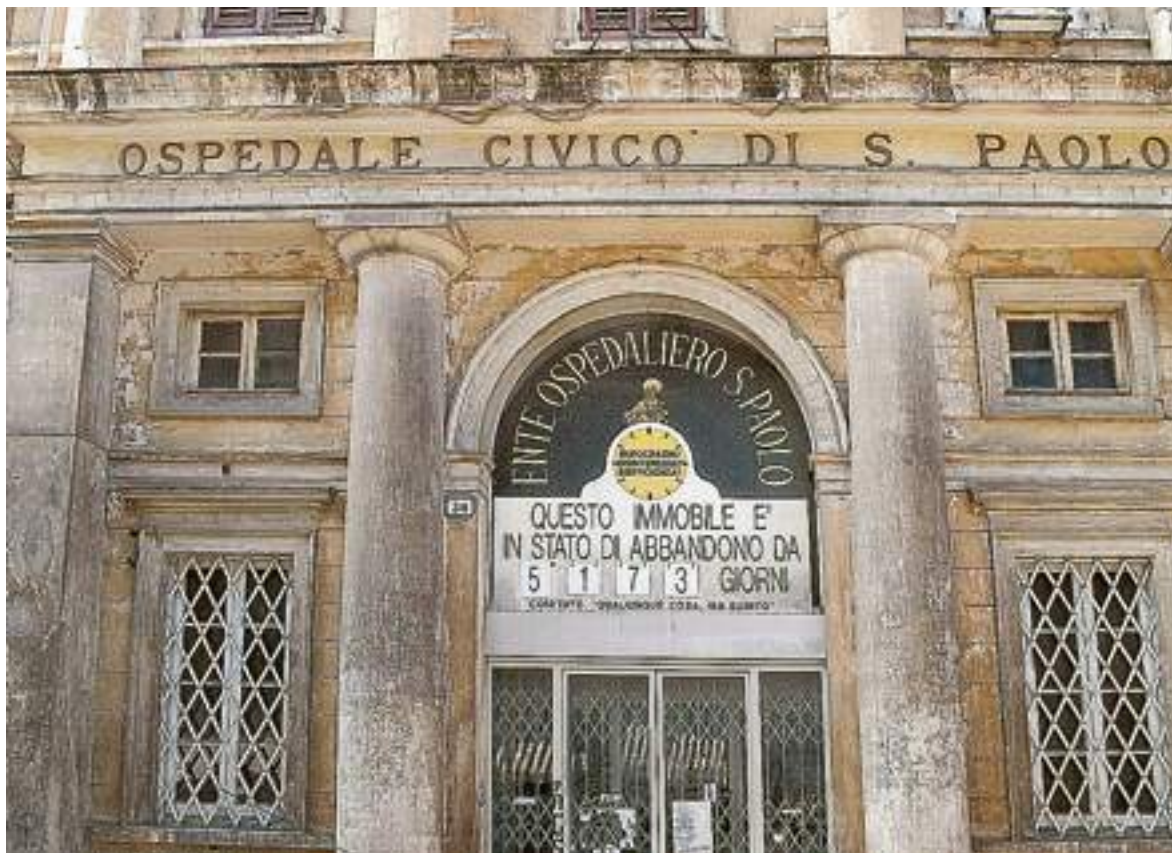
Finalmente il cartello che certifica i giorni di abbandono del San Paolo verrà rimosso dal cantiere della rinascita
