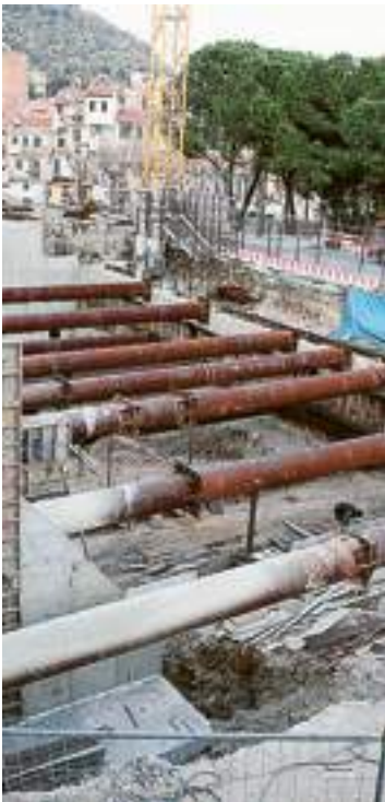
Il cantiere di via Belvedere
