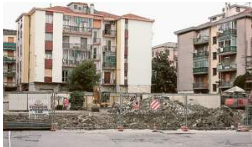
Il cantiere di via San Pietro
