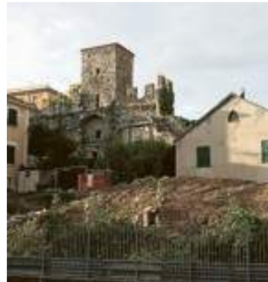
L'area del cantiere
