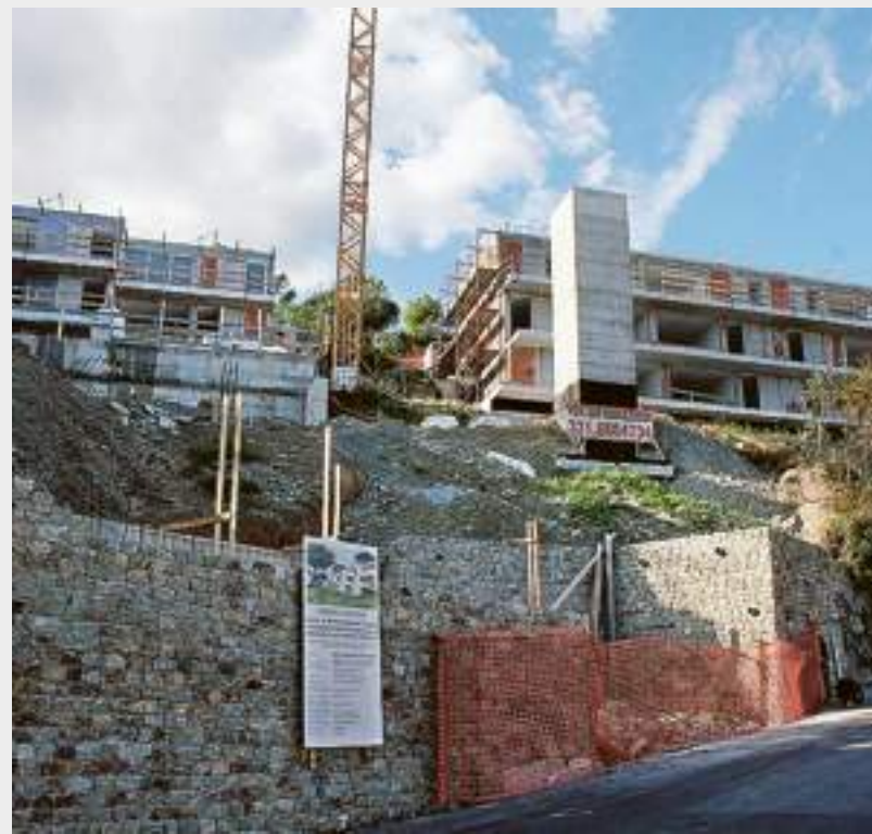
Lavori fermi al cantiere dell'ex hotel Pineta di Spotorno
