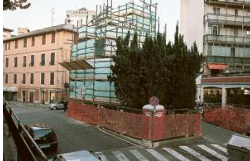
San Michele, l'area verde occuperà la strada lato palazzi
