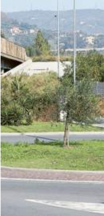
La rampa della superstrada
