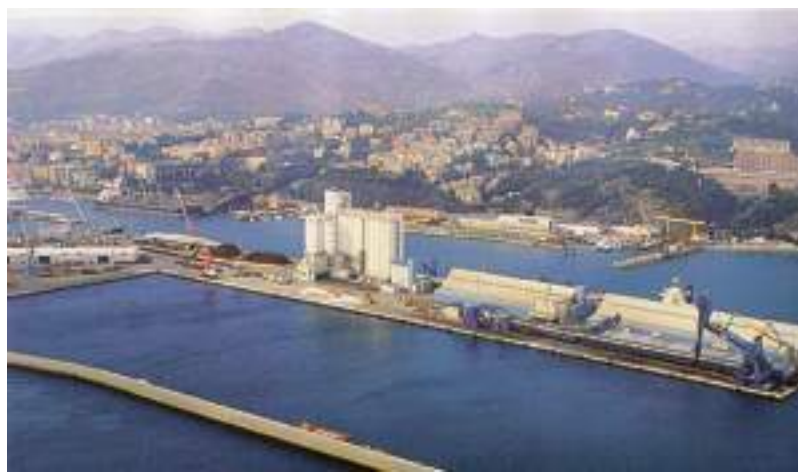
Il terminal Alti Fondali di Savona
