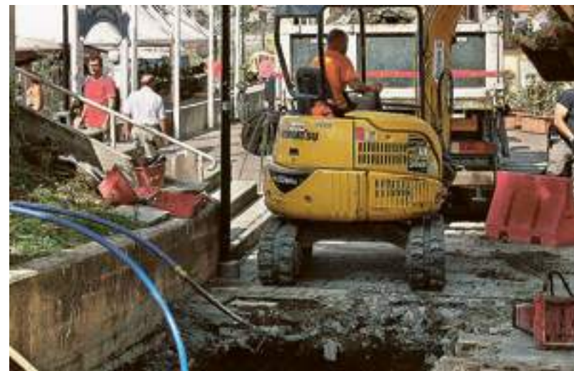
Ruspa in azione sulla passeggiata di Albisola il luglio scorso per la rottura della condotta. Il prossimo anno la rete verrà spostata lungo la spiaggia
