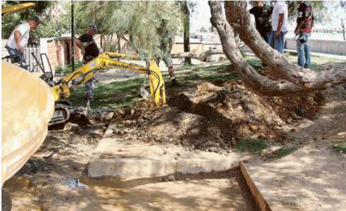
I lavori d'urgenza per i guasti alla fognatura alla fine dello scorso agosto
