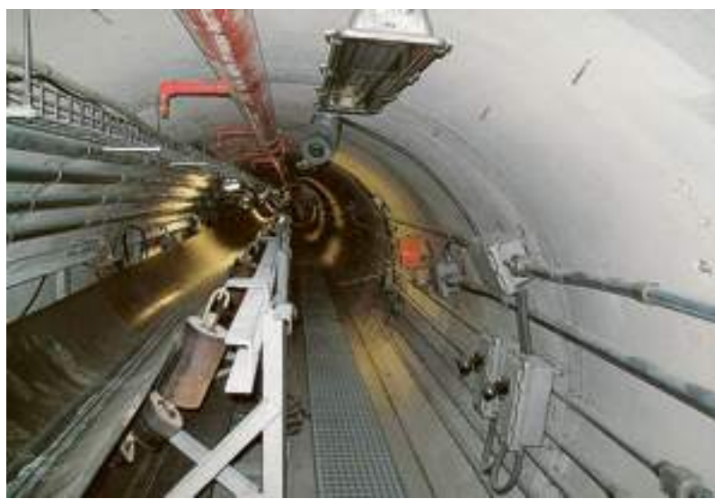
L'interno del tunnel che passa sotto il mare e la città
