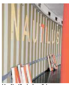
L'ex Nautilus in demolizione
