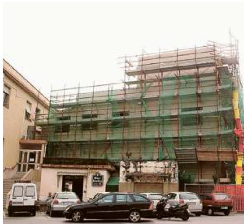
L'edificio del porto durante i lavori di ristrutturazione
