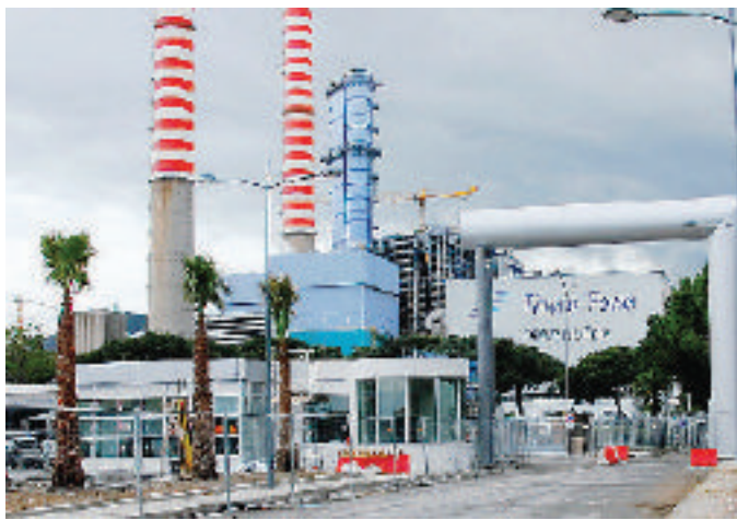
La centrale della Tirreno Power di Vado Ligure
