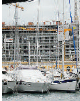
La zona del nuovo parcheggio
