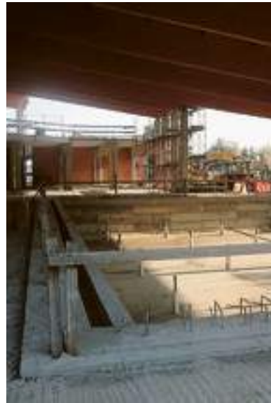
La struttura della piscina coperta
