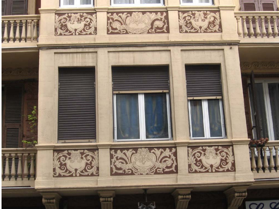
Figura 3. Palazzo in Via San Lorenzo. Particolare
