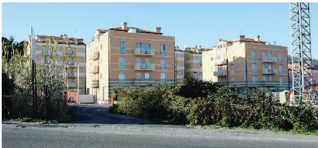
Nuovo quartiere E' sorto nelle immediate vicinanze di Legino e del casello autostradale di Zinola
