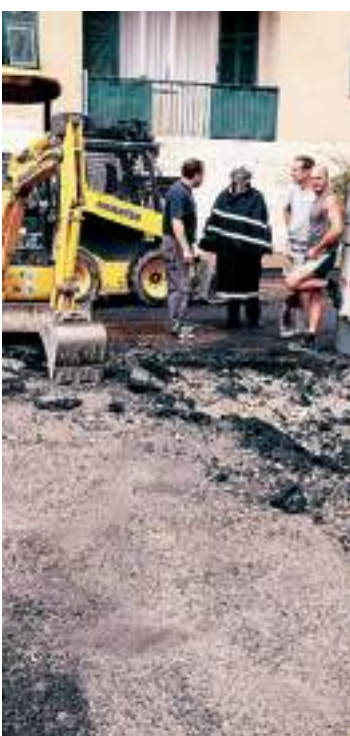
Lavori in piazza Bologna
