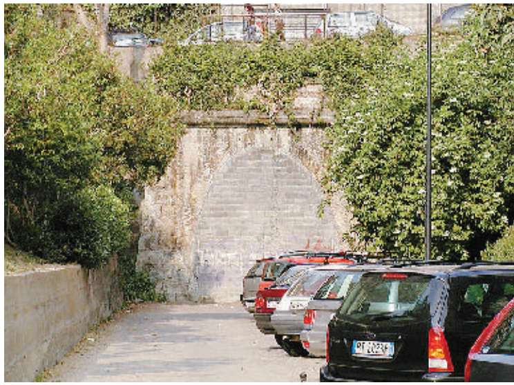
Lo sbocco murato del vecchio tracciato ferroviario in via Falletti
