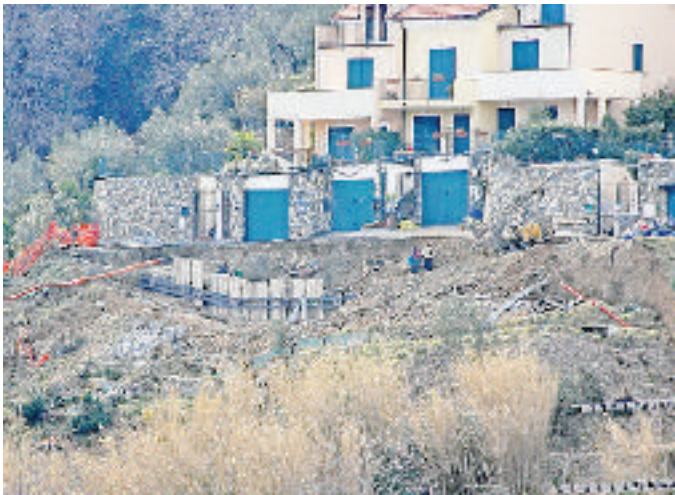
Continuano i lavori per mettere in sicurezza la collina di Poggio del Sole
