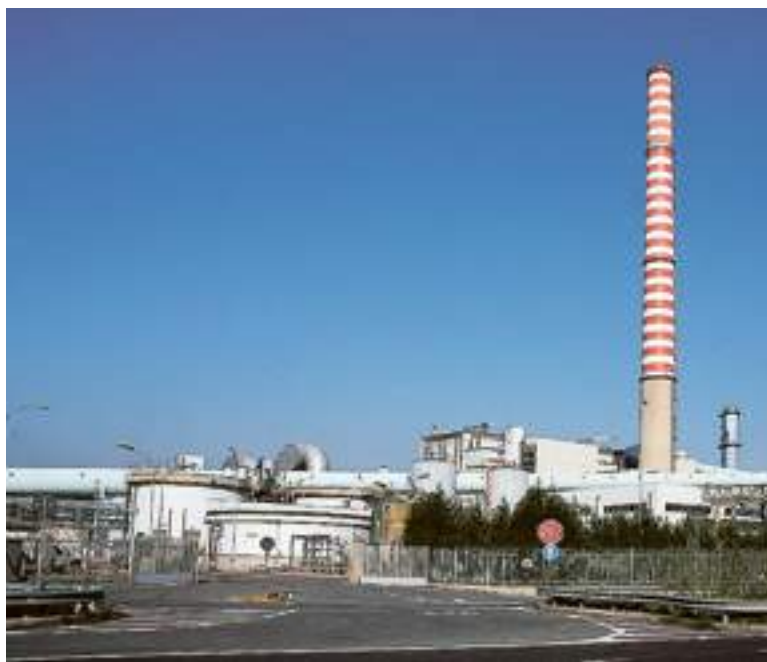
La centrale di Vado
