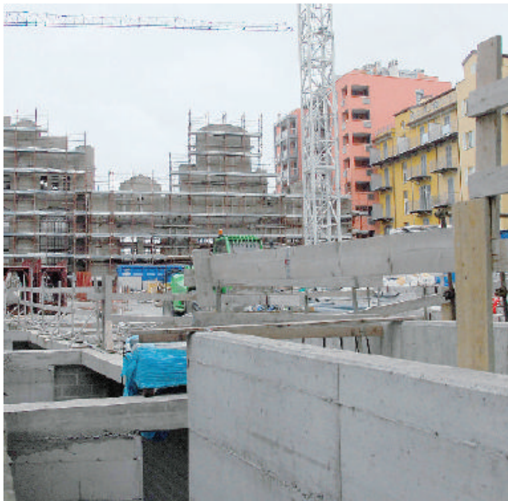
Il complesso dell'ex centrale Enel di corso Veneto ospiterà appartamenti, due supermercati e negozi
