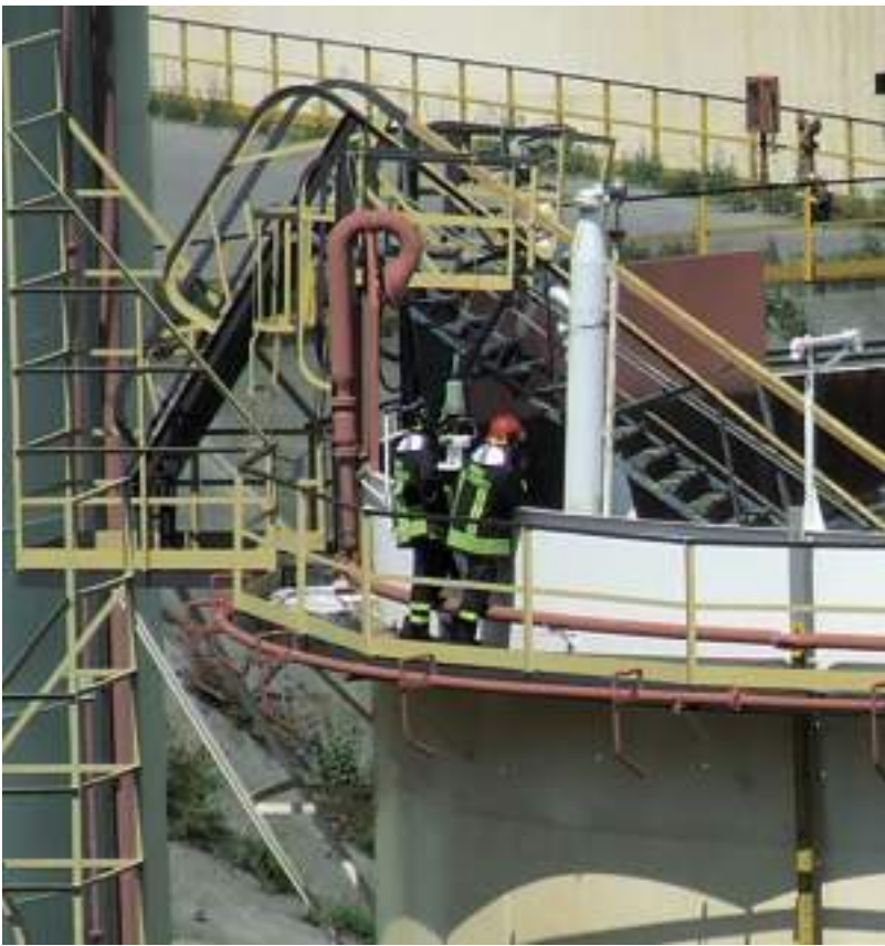
Il serbatoio della Petrolog di Vado Ligure
