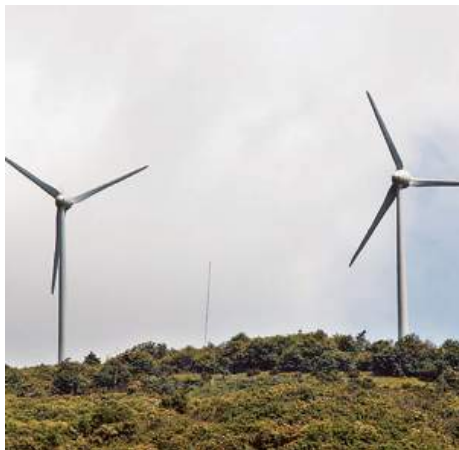
Le pale della centrale eolica di Stella San Martino
