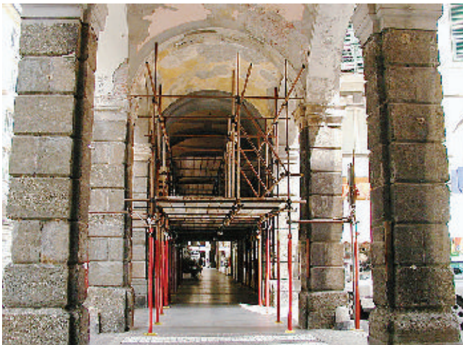
Le impalcature sono nel tratto verso l'incrocio con via Manzoni
