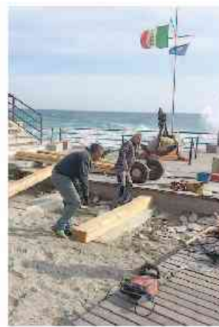
Il cantiere di piazza del Mare
