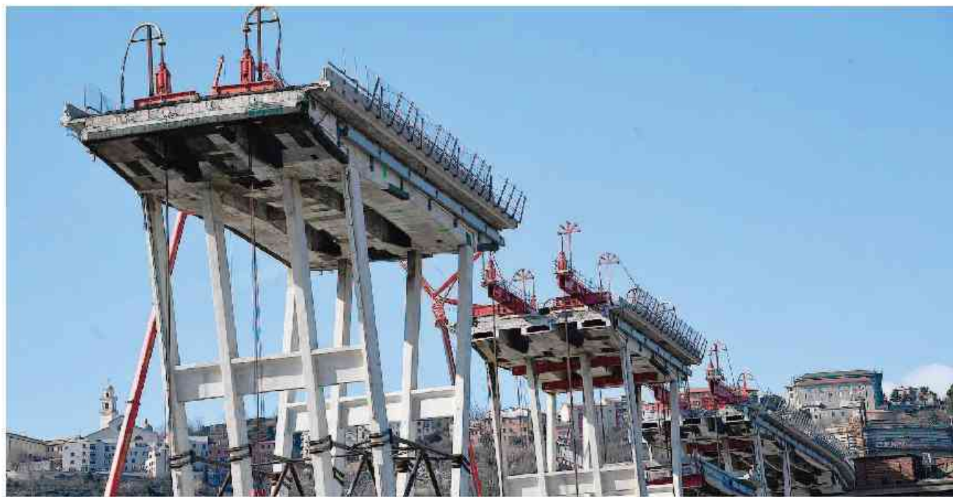
Rinviata la demolizione della pila 8 di Ponte Morandi con la dinamite perchè sono state scoperte tracce di amianto nel calcestruzzo
