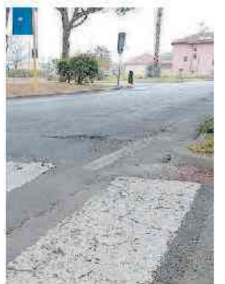
Lavori in via dei Gazzi
