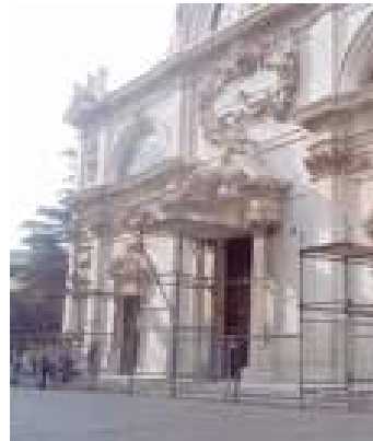
Le impalcature del Duomo
