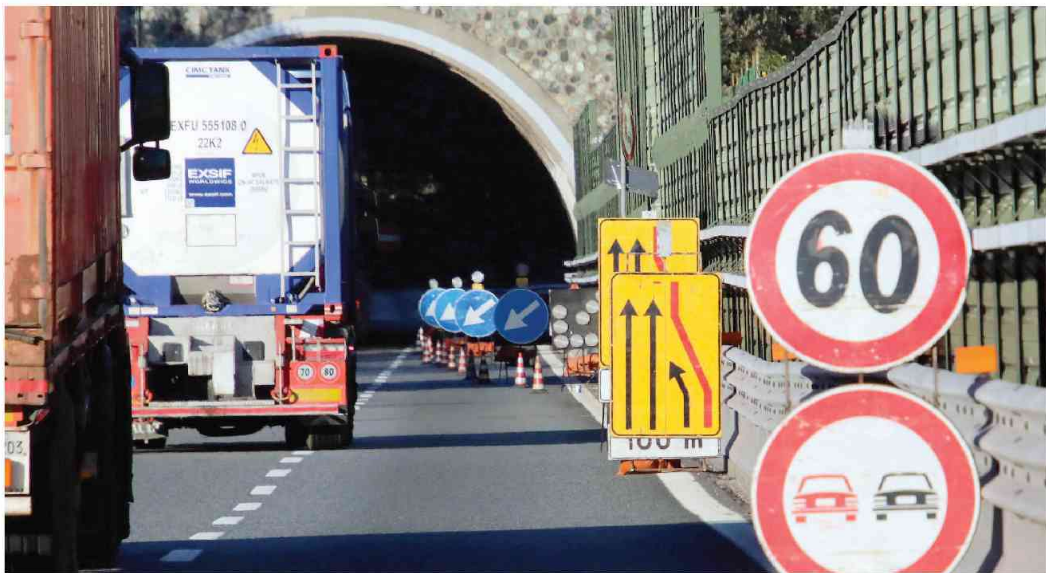
La sequenza di cantieri in autostrada causa disagi ai pendolari e soprattutto ai turisti che arrivano nel fine settimana in Riviera
