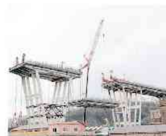
Le operazioni per la demolizione
