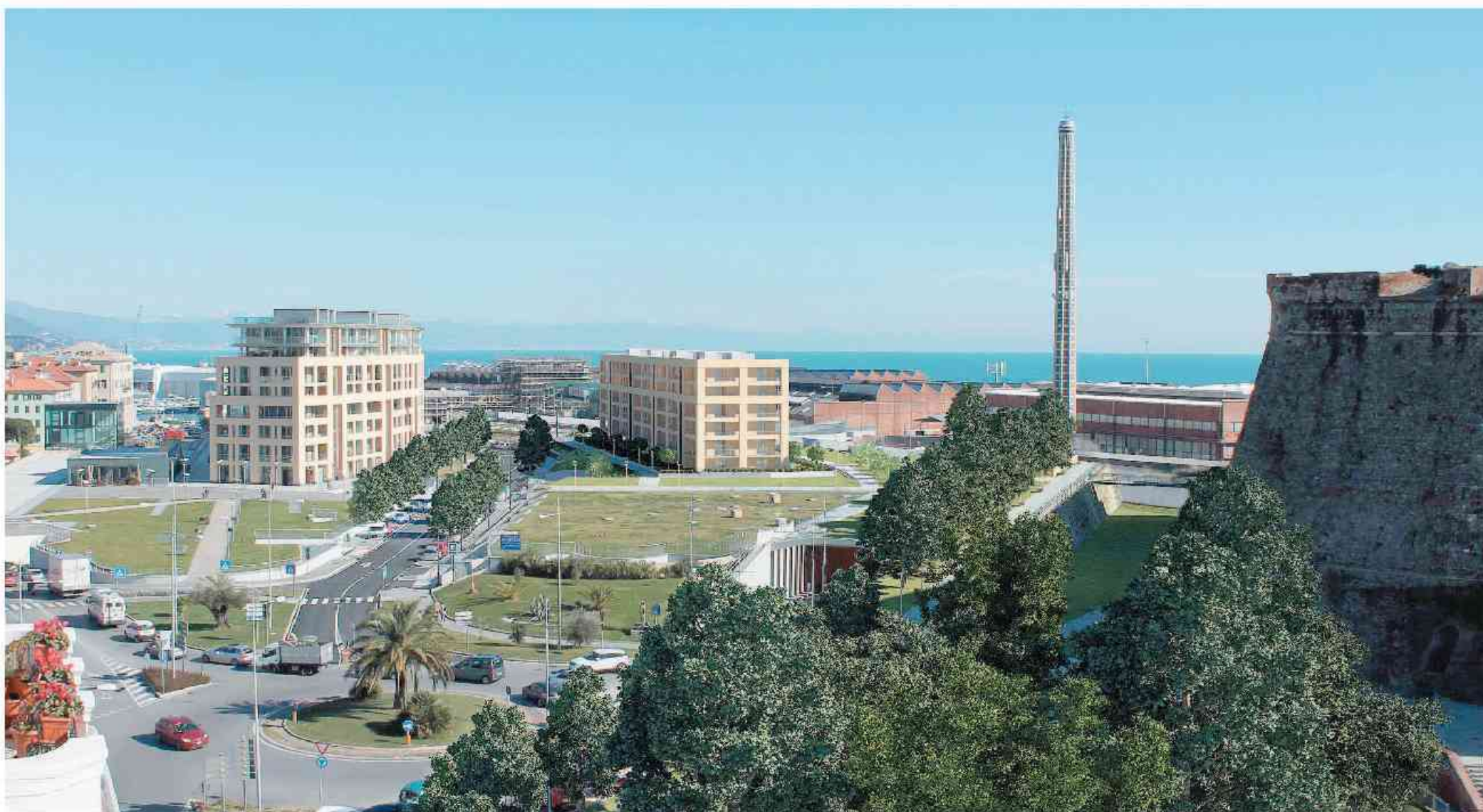
In questa immagine, elaborata al computer, si vede a sinistra l'attuale edificio semicircolare del Crescent 1 e, più a destra, un rendering del Crescent 2, che sarà rettangolare
