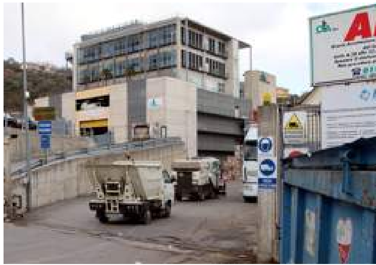
Il centro di smaltimento di Ata in via Caravaggio
