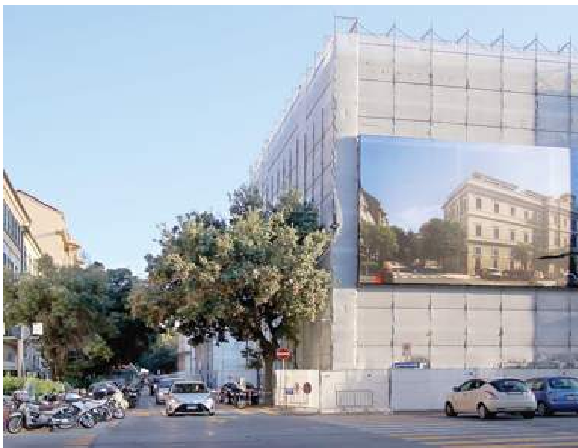
L'uscita del tratto di corso Italia in piazza Giulio: da metà settembre sarà chiuso al traffico
