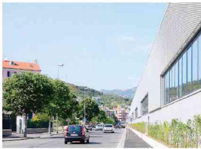
La zona del lavaggio treni che si affaccia su via Vittime di Brescia
