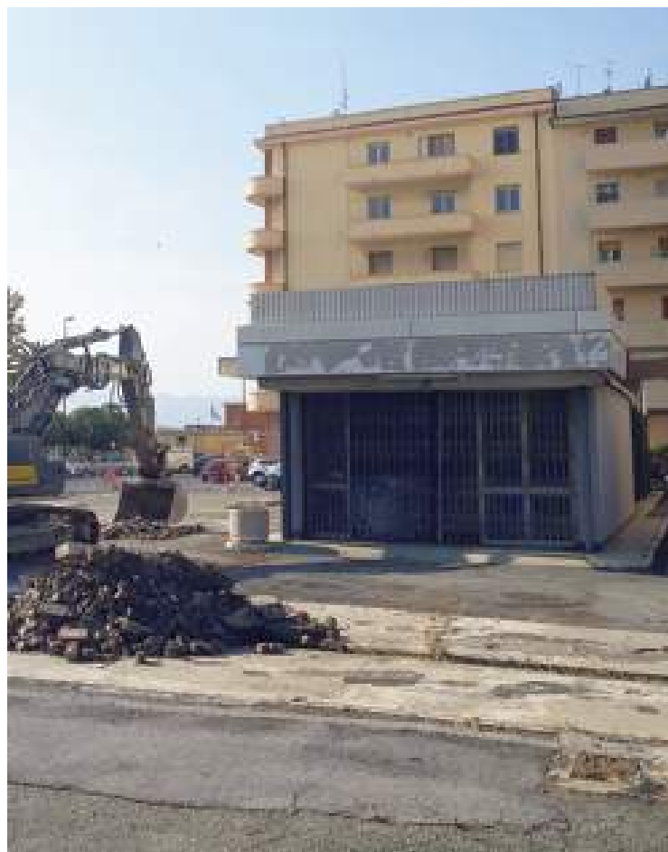
La demolizione del distributore
