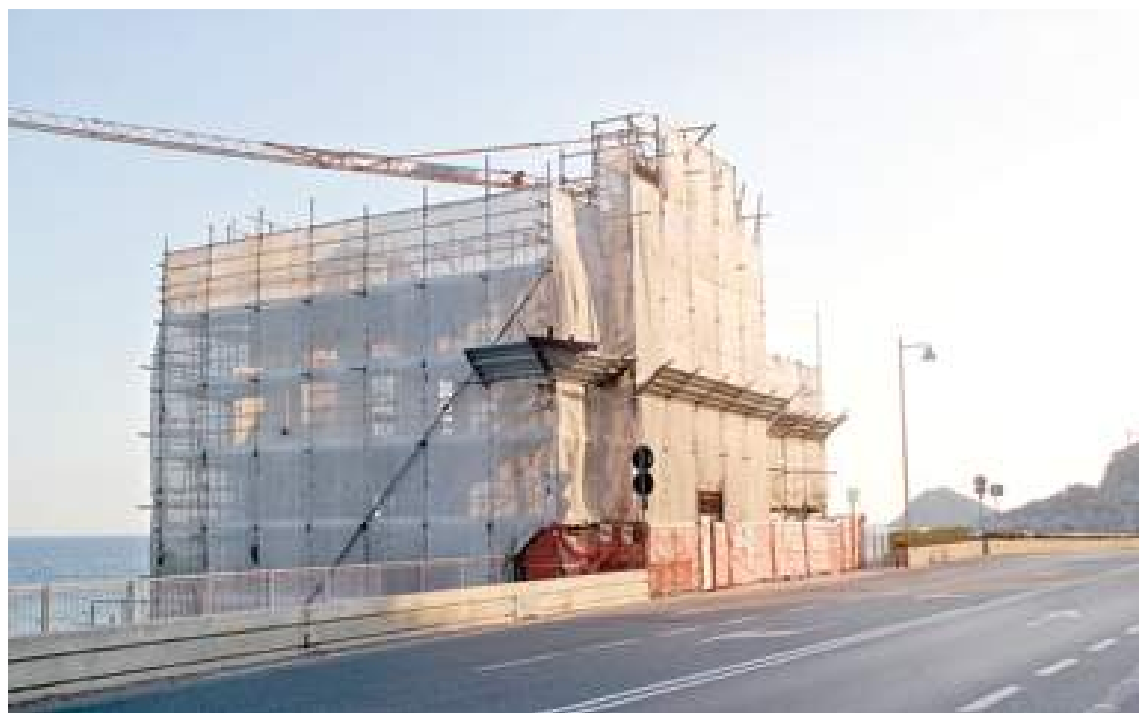
L'impalcatura che ha ingabbiato l'ex ristorante il Faro
