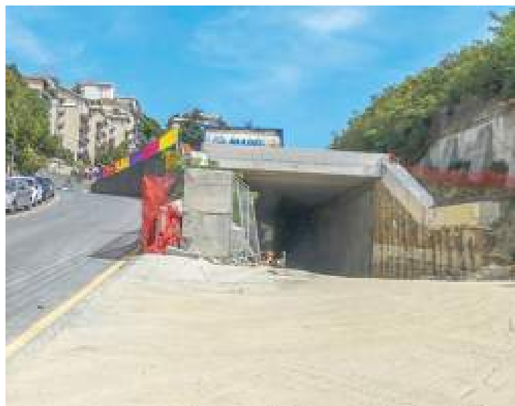
Il cantiere arrivato alla Rusca
